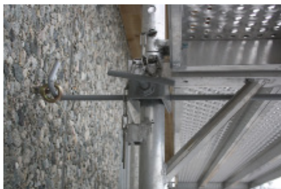
Et veggfeste korrekt montert på innerspiret.
